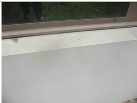
Matériaux : ZPSO-018 Prélèvement : P015; P016; P017; P018 Description : Enduit + peinture (sur béton) Localisation : Façade sud-ouest; Façade nord-ouest; Façade nord-est; Façade sud-est - allèges de fenêtres Résultat : Absence d'amiante
