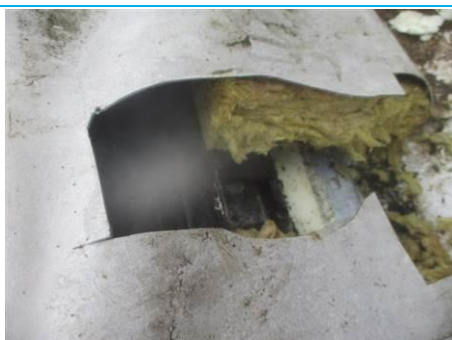
Matériaux : ZPSO-003 Prélèvement : P005; P006 Description : revêtement bitumineux Localisation : Toiture terrasse - relevés acrotères; lanternaux (sous membranes PVC) Résultat : Absence d'amiante
