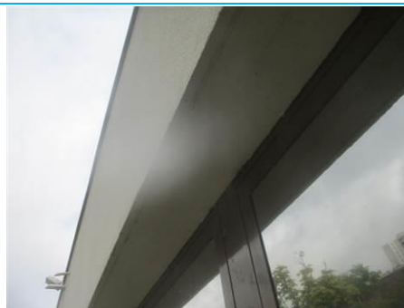
Matériaux : ZPSO-019 Prélèvement : P019; P020; P021; P022 Description : Peinture blanche /beige (sur béton) Localisation : Façade sud-ouest; Façade nord-ouest; Façade nord-est; Façade sud-est - linteau, haut du tableau Résultat : Absence d'amiante
