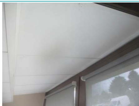
Matériaux : ZPSO-020 Prélèvement : Description : Faux-plafond blanc (60*60cm) laine minérale - année 2012 Localisation : Intérieur / périphérie bâtiment Résultat : Absence d'amiante
