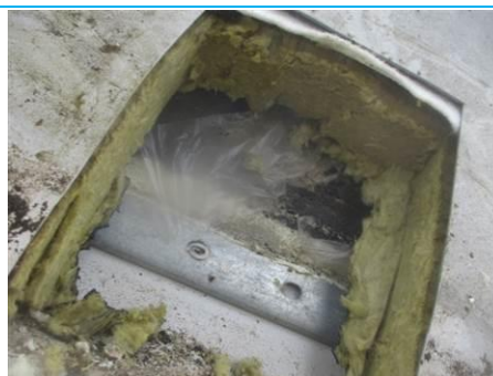
Matériaux : ZPSO-003 Prélèvement : P005; P006 Description : revêtement bitumineux Localisation : Toiture terrasse - relevés acrotères; lanternaux (sous membranes PVC) Résultat : Absence d'amiante
