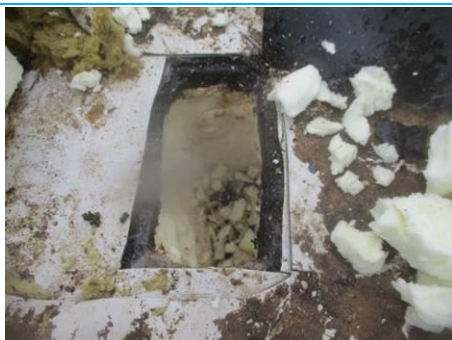
Matériaux : ZPSO-001 Prélèvement : P001; P002 Description : revêtement bitumineux bicouche + isolant polyuréthane Localisation : Toiture terrasse - sous membrane PVC Résultat : Absence d'amiante
