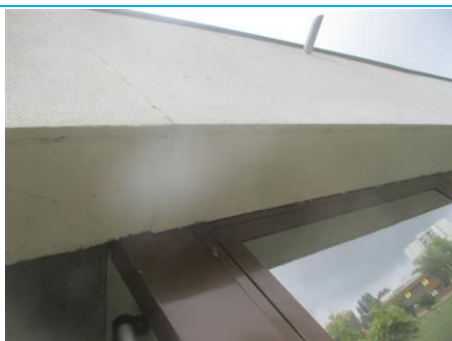
Matériaux : ZPSO-019 Prélèvement : P019; P020; P021; P022 Description : Peinture blanche /beige (sur béton) Localisation : Façade sud-ouest; Façade nord-ouest; Façade nord-est; Façade sud-est - linteau, haut du tableau Résultat : Absence d'amiante
